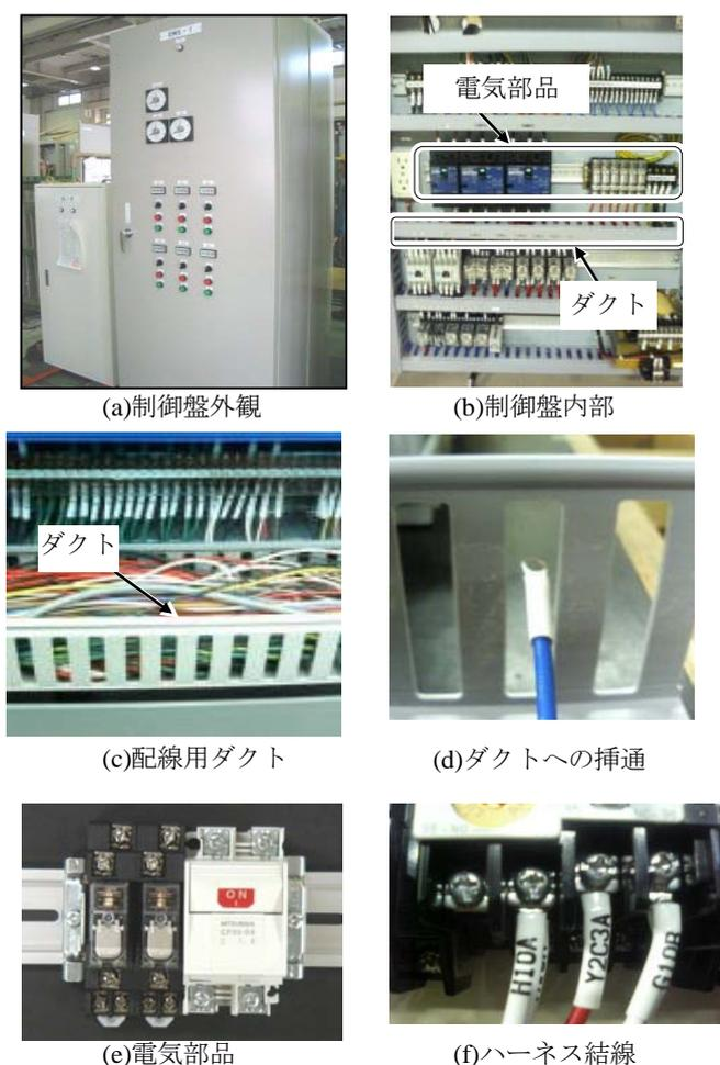
図1 制御盤の概要
