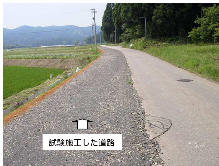
図9 拡幅工事現場
