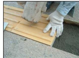
図1 ブロック交換による補修
