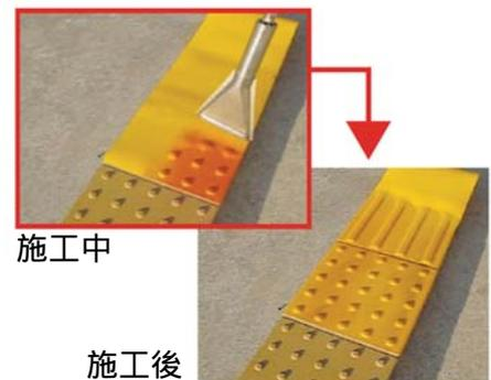
図2 クイックシートによる補修
