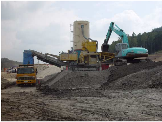
改良対象土と安定材とを混合する施工機械 (土質改良機－リテラ－連続攪拌)－写真①
