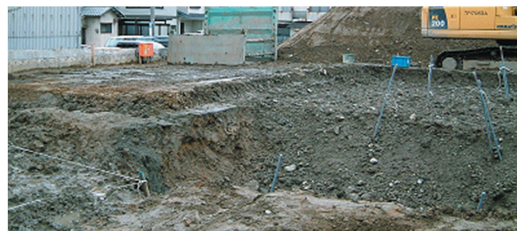
□ 給油所跡地の土壌修復現場(株)ゲイト提供)
