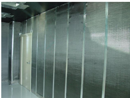
電磁波シールドモデルオフィスルーム 工事中のシールド材料の施工様子
