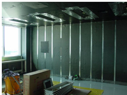
電磁波シールドモデルオフィスルーム 工事中のシールド材料の施工様子
